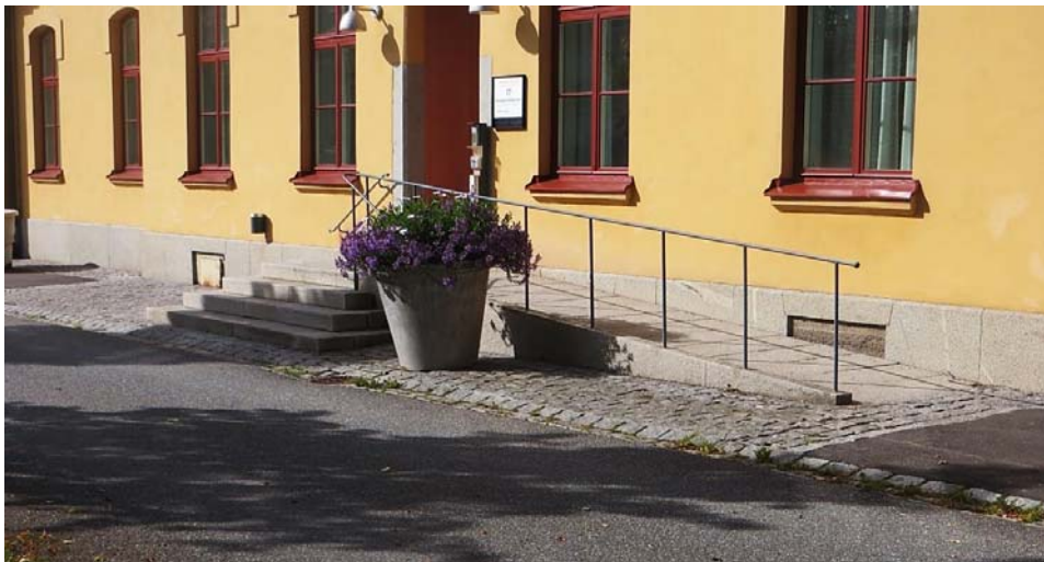
ramp med avåkningskydd
