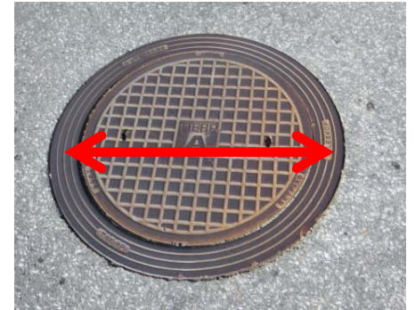
Brunnslockets ytterdiameter 64 cm
